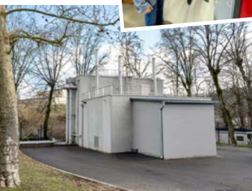
Chaudière biomasse à proximité du site Ardant du Picq, alimentant déjà le nouvel EHPAD Les Hirondelles ainsi que des logements CDC Habitat.
