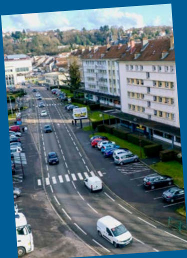
De nombreux travaux de voirie ont été réalisés
