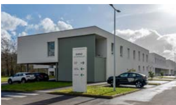
Nouvel EHPAD Les Hirondelles, chauffé grâce à une énergie économique et renouvelable produite par la chaudière biomasse.
