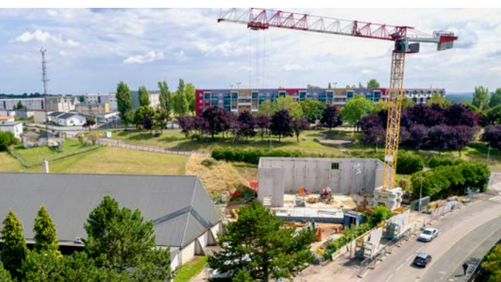
Nouvelle chaudière biomasse – quartier Wenheck, avec une extension du réseau vers le site de l'IUT de Moselle-Est
